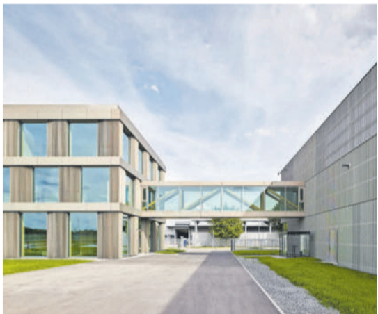
HK Architekten zeigt mit dem Schraubenwerk Waldenburg, wie mit Holz in der Industrie gebaut werden kann.
